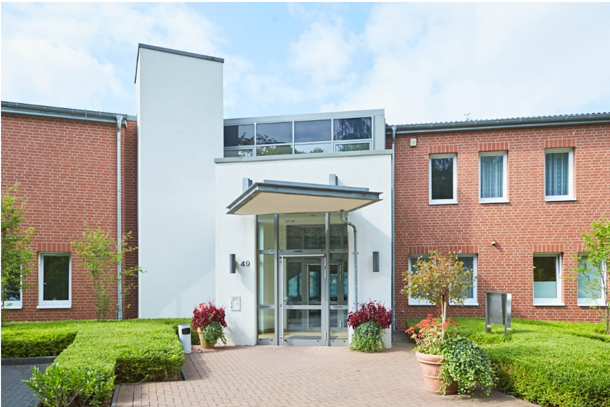
Tagesklinik Ahlen (Haupteingang)
